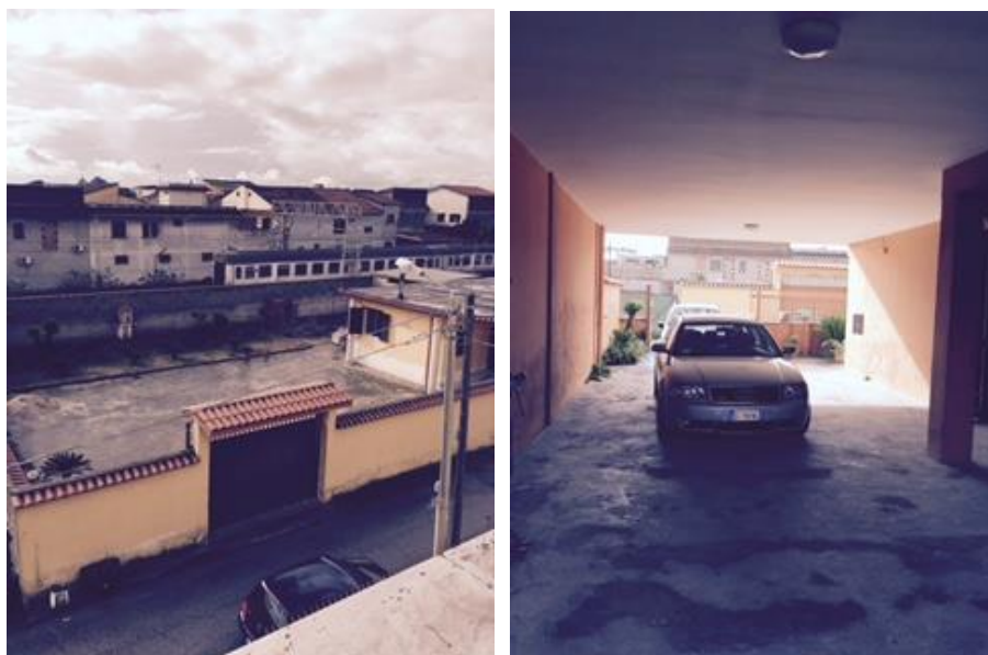
Vista dall'alto – prospetto su linea ferroviaria; Porticato: foto 5 e 6
