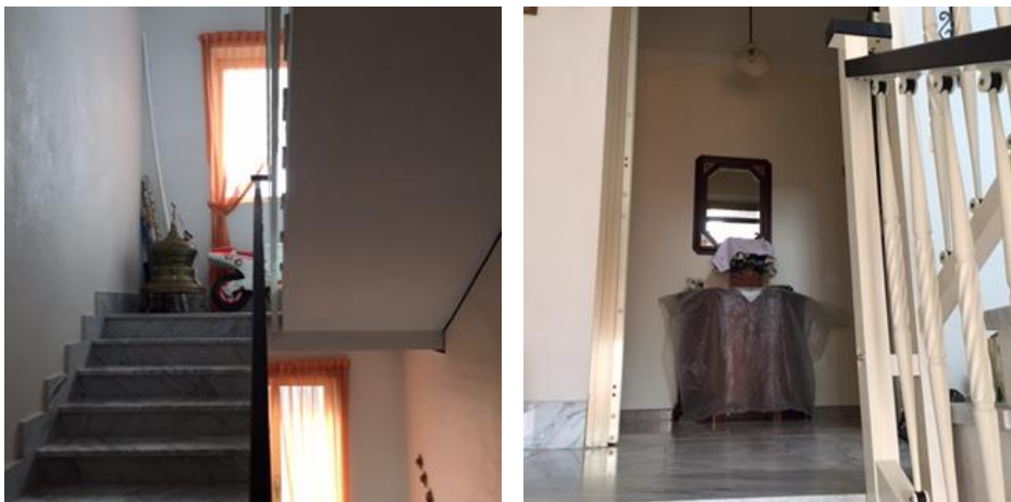
Scala e accesso all'unità al primo piano: foto 11 e 12
