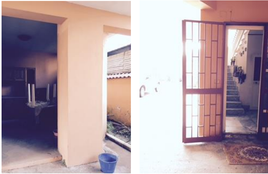
Deposito al piano terra; ingresso vano scala: foto 9 e 10
