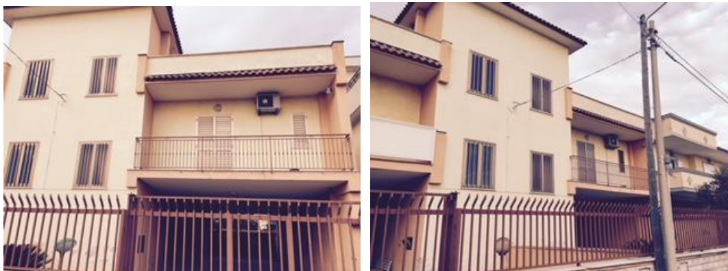
Prospetto principale: foto 1 e 2
